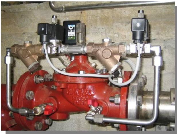
e-Smart: Aplicación con control de la válvula paso a paso, para control de nivel en un depósito
