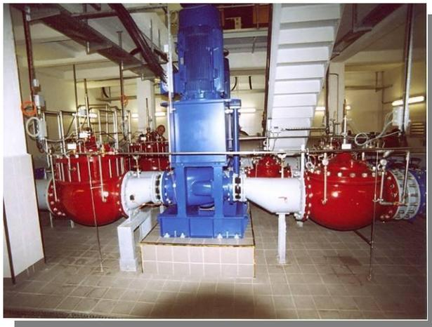
Válvulas de control de bombas / turbinas para estación de bombeo / turbinado
