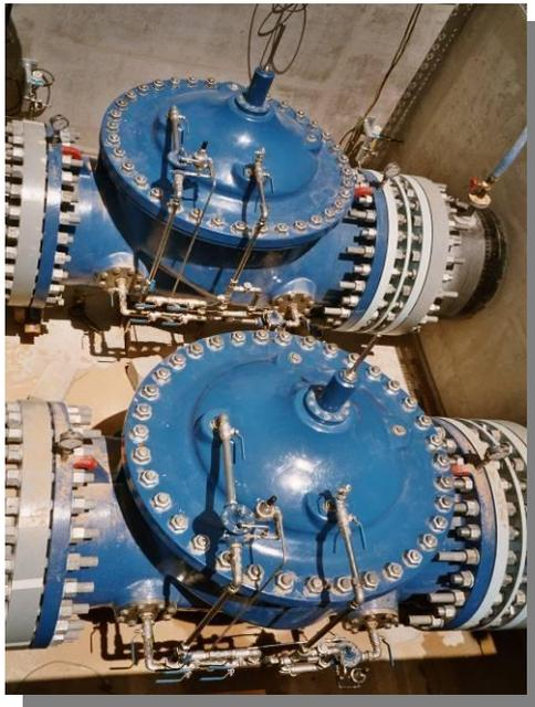
Estabilizador de presión aguas abajo serie TYTAN para conducción doble DN 1400 mm
