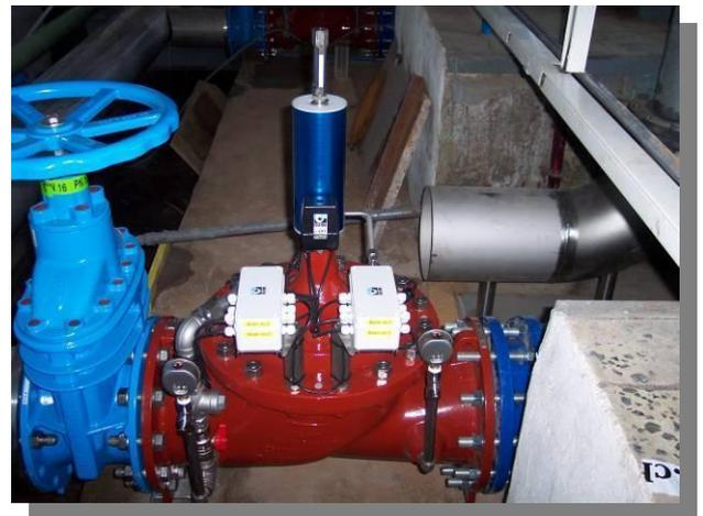
e-Smart: Aplicación para limitar los golpes de ariete, después de una renovación de estación de bombeo
