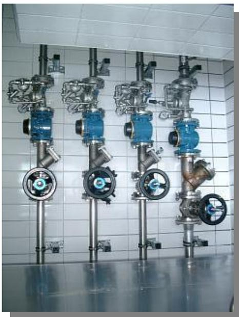
Estabilizador de presión DN 100 mm en acero inox,
